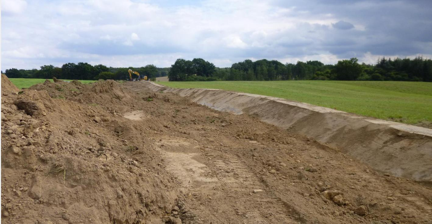
August/September: Wallbau durch Seitenentnahme, Arbeitsbreite ca. 18 m
